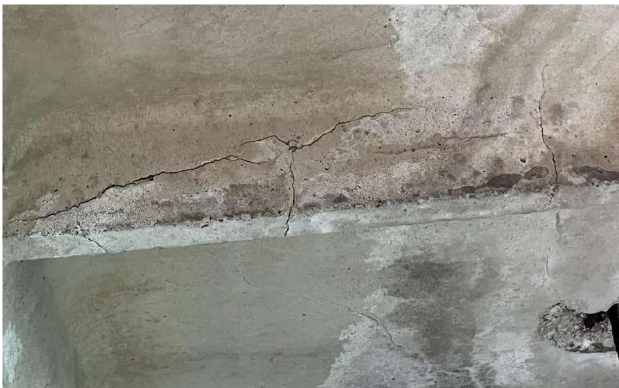
7 pav. Skersinėse denginio plokščių briaunose apsauginis betono sluoksnis suaižėjęs
